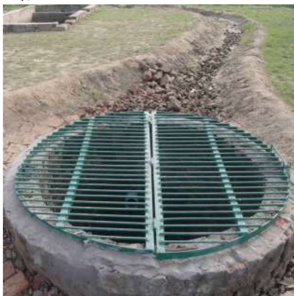
अपवाहित वर्षा जल के साथ बहने वाली रेत को रोकने के लिये गड़ढ़ा और ढका हुआ परित्यक्त कुंआ
